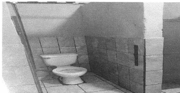
Foto 4: sustición de puerta en servicio sanitario.
