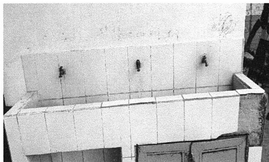
Foto 21: Instalación de chorros
