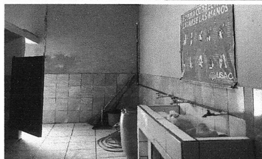
FOTO 24: Instalación de Chorros
