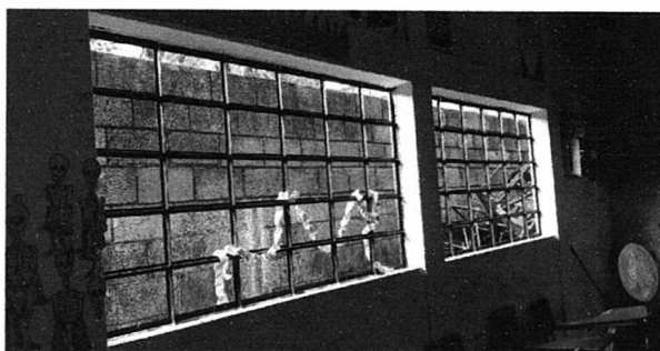
FOTO 6: Sustitución de ventana de metal por ventana de PVC
