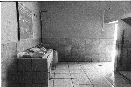
FOTO 25: Instalación de chorros
