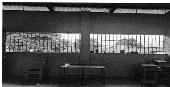
FOTO 12: Sustitución de ventana de metal por ventana de PVC
