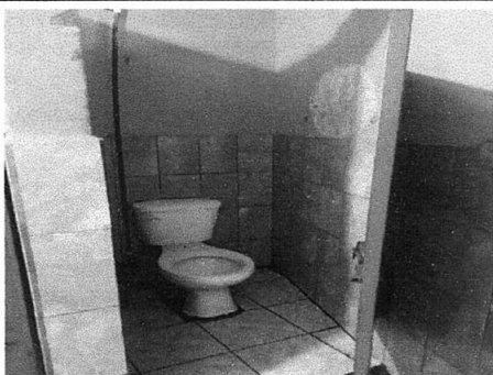
FOTO 27: Sustitución de inodoro
