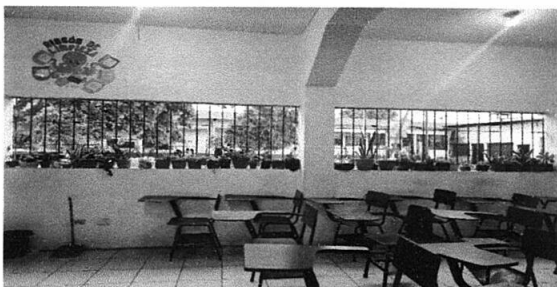
FOTO 9: Sustitución de ventana de metal por ventana de PVC
