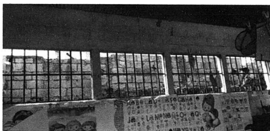
FOTO 7: Sustitución de ventana de metal por ventana de PVC
