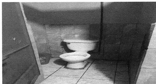
FOTO 26: Mantenimiento a puertas de sanitario
