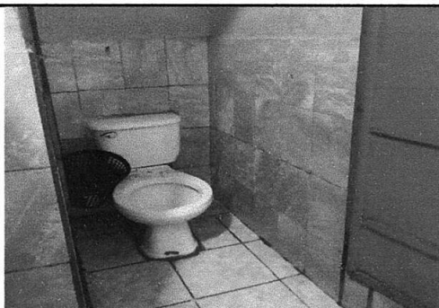
FOTO 23: Sustrucción de inodoro
