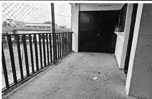
foto 14; Sustitución de piso de torta de concreto , por piso cerámico.
