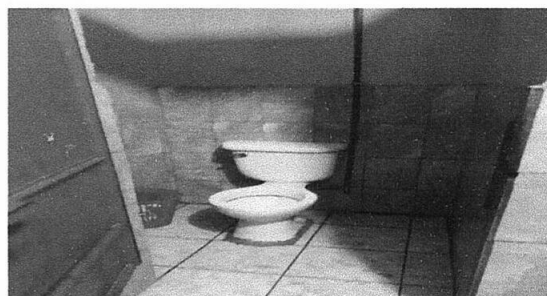
FOTO 22: Sustrucción de inodoro
