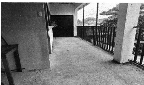
FOTO 13: Sustitución de piso de torta de concreto, por piso ceramico.
