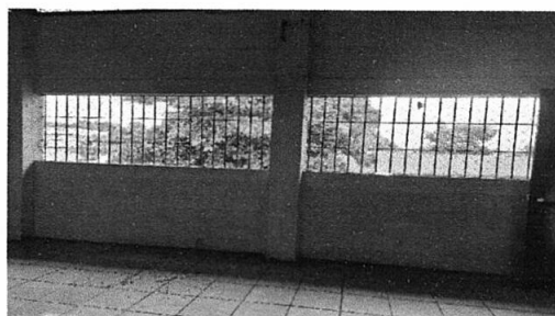
FOTO 10: Sustitución de ventana de metal por ventana de PVC
