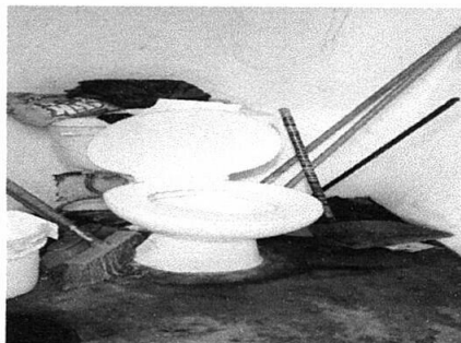
FOTO 16: Sustitución de inodoro
