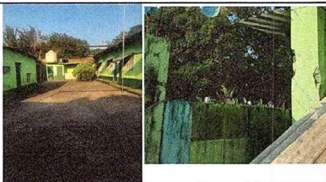
Foto 5: Pintura en muros interior y exterior
