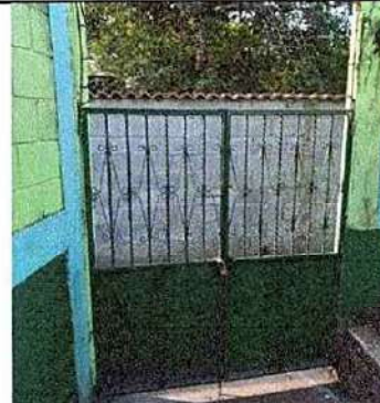
Foto 2: Sustrucción de portón de metal
