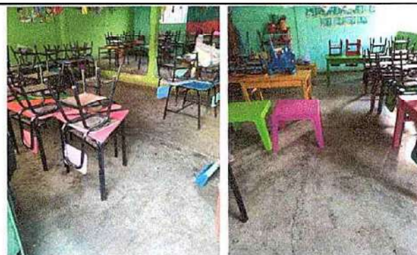
Foto 4: Sustrucción de piso de torta de concreto
