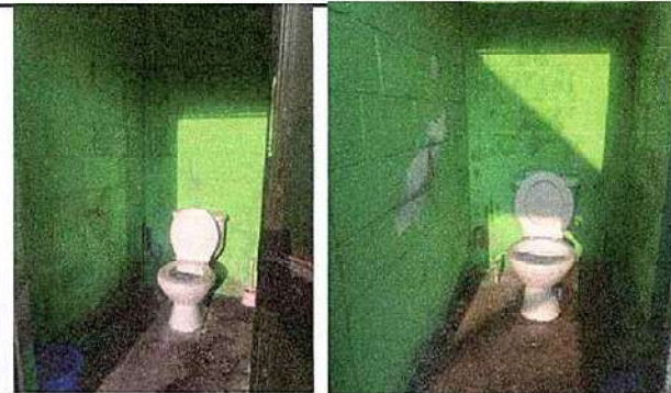
Foto 6: Sustrucción de inodoros
