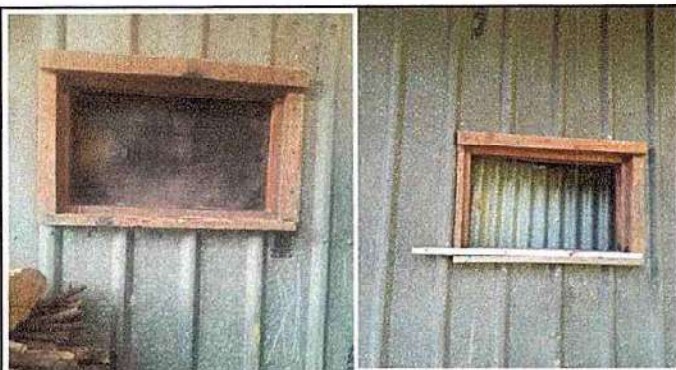
Foto 3: Sustrucción de ventanas
