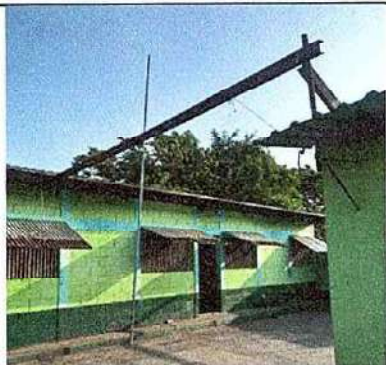
Foto 1: Sustrucción de lámina por lámina troquelada calibre 26
