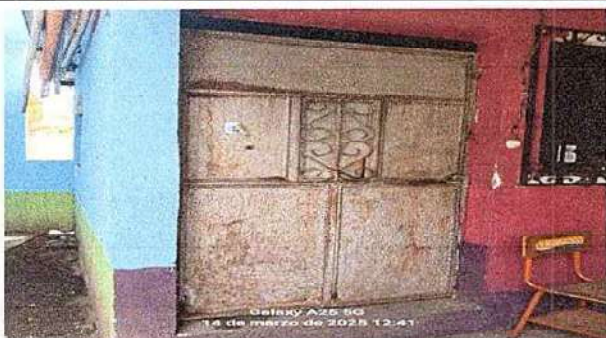
Foto 5: 4.3 Sustitución de puerta
