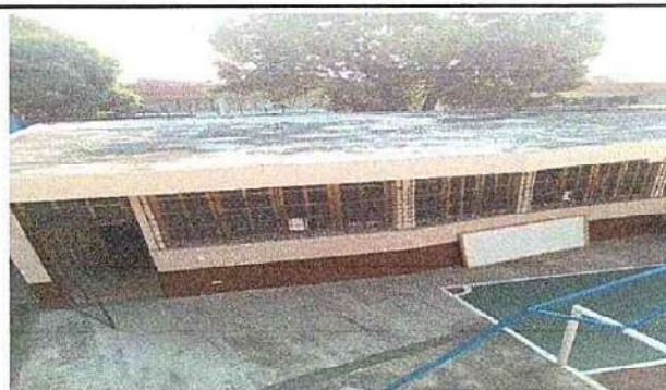
Foto 4: 3.1 Impermeabilización de losa
