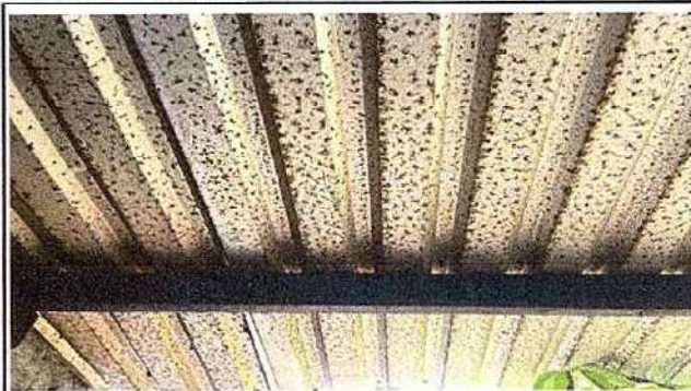
Foto 2: 1.2 Sustitución de capote de lámina para lámina troquelada
