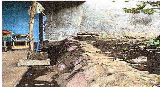
Foto 8: 15.1 Reparación de muro perimetral de block
