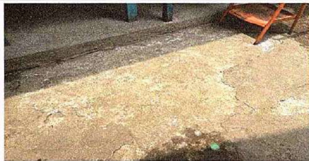
Foto 6: 6.1 Reparación de piso de torta de concreto
