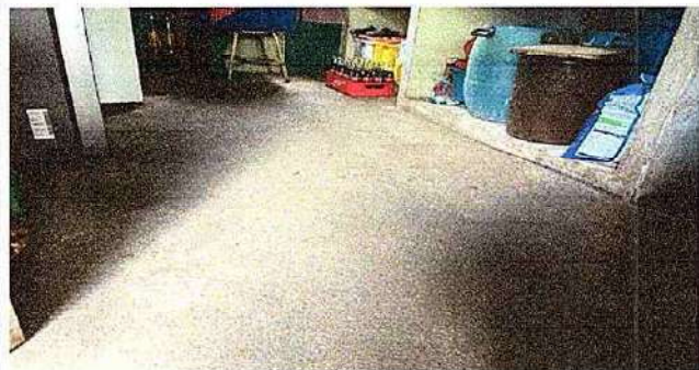
Foto 7: 6.5 Sustitución de piso de torta de concreto
