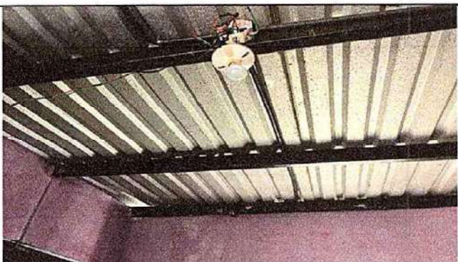
Foto 3: 1.3 Sustitución de elementos de fijación
