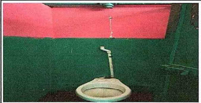
Foto 10: Sustitución de baños y tubería
