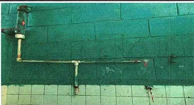
Foto 11: Sustitución de azulejo
