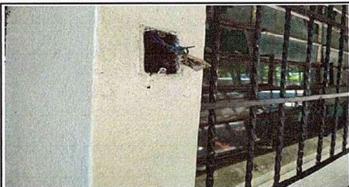
Foto 1: Sustrucción de interruptores
