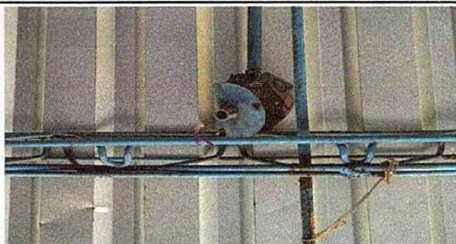
Foto 4: Sustrucción de cajas hexagonales y tubería
