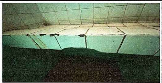
Foto 12: Sustitución de azulejo módulo 2
