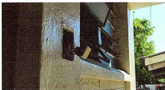
Foto 5: Sustrucción de interruptores exteriores
