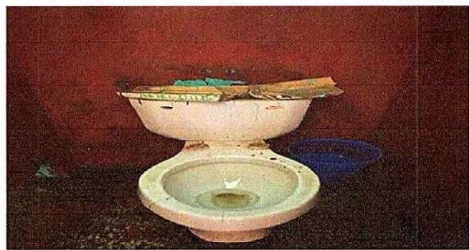
Foto 9: Sustitución de baños
