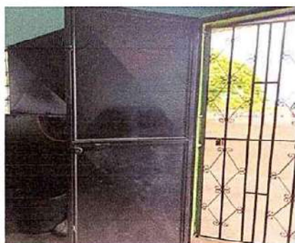
Foto 15: Salón 8 mantenimiento de puerta
