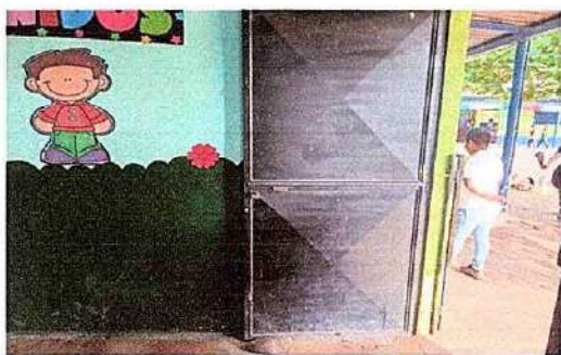
Foto 3: Salón 6 mantenimiento de puerta
