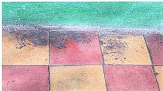
Foto13: Salon 8 Sustitucion de piso
