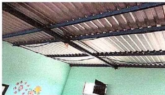
Foto 2: Salon 6 sustitucion de focos ahorradores, plafoneras, interruptores simples, tomacorrientes dobles, cableado electrico, ducto electrico y accesorios
