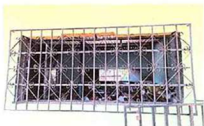
Foto 11: Saló 7 manteminiento a balcones
