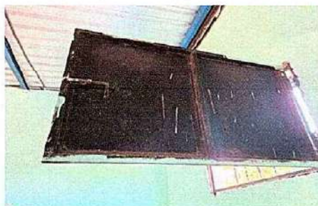
Foto 4: Salón 6 Mantenimiento a ventana
