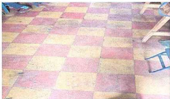
Foto 7: Salon 7 Sustitucion de piso
