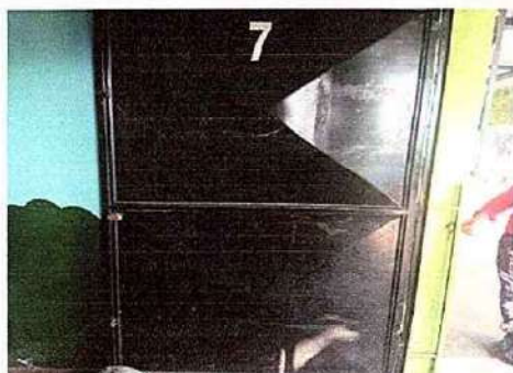
Foto 9: Salón 7 mantenimiento de puerta
