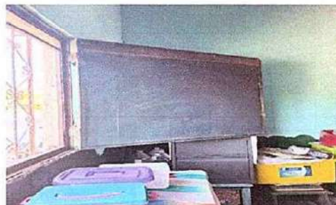
Foto 10: Salón 7 mantenimiento a ventana
