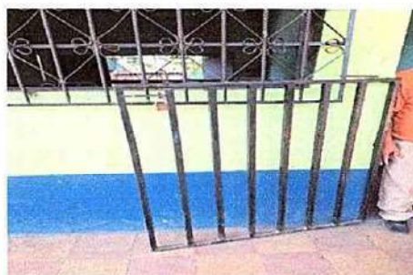
Foto 12: Salón 7 mantenimiento a baranda
