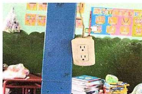
Foto 14: Salon 8 sustitución de focos ahorradores, plafoneras, interruptores simples, tomacorrientes dobles, cableado eléctrico, ducto eléctrico y accesorios
