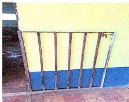
Foto 6: Salón 6 Mantenimiento a baranda
