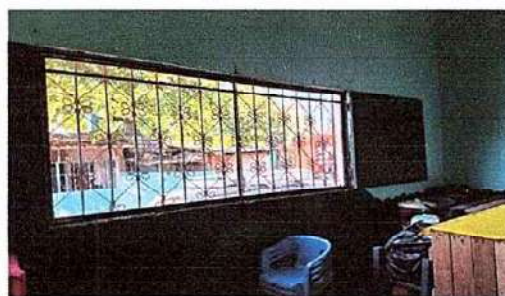
Foto 16: Salón 8 mantenimiento a ventana
