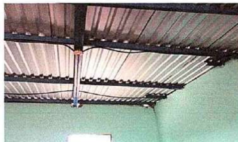
Foto 8: Salon 7 sustitucion de focos ahorradores, plafoneras, interruptores simples, interruptores dobles, cableado eléctrico, ducto eléctrico y accesorios
