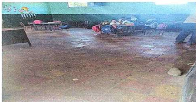
Foto1: Salón 6 Sustitucion de piso de granito
