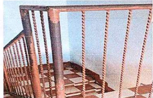
Foto 8: Renglon de trabajo 11 mantenimiento de barandas
