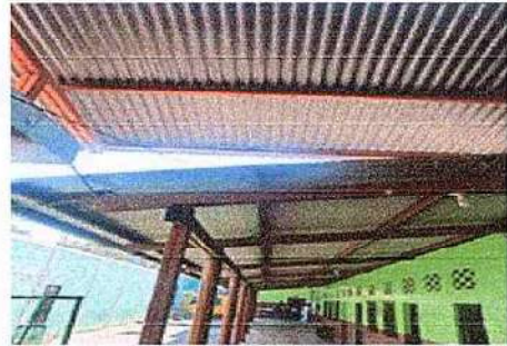
Foto 2: Renglón de trabajo 2 Estructura de techo.
