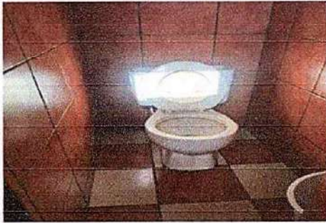
Foto 6: Renglon de trabajo 10 Servicios Sanitarios y sus accesorios
