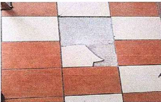
Foto 5: Renglón de trabajo 6 Piso (Sustitución de una area piso ceramico)
