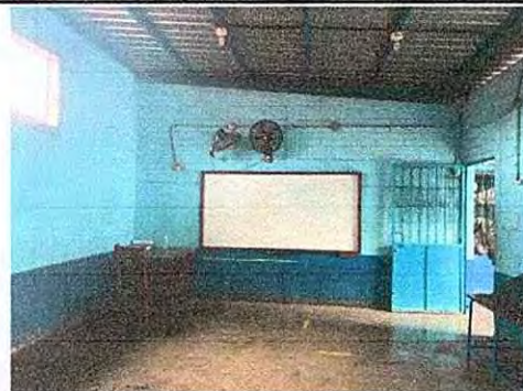
Foto 6: Pintura en muros exteriores e interiores
