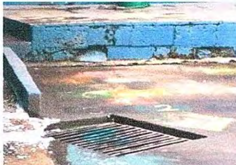
Foto 4: Reparación de tapadera de caja
