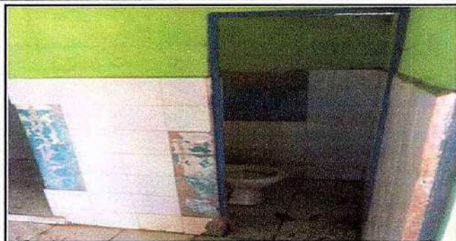
Foto1: 4.4 Sustitucion de puertas en sanitarios
