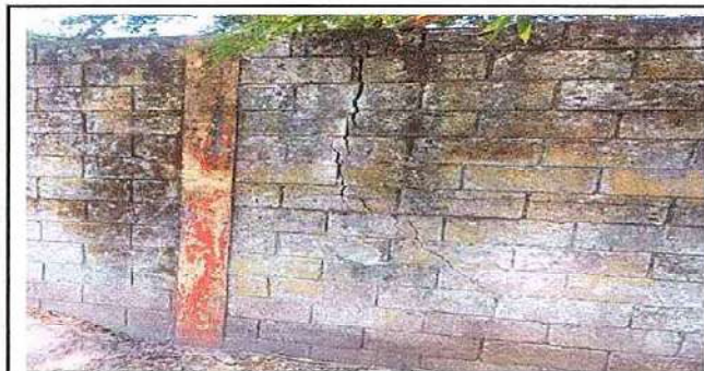
Foto 3: Reparación de muro perimetral de block.
