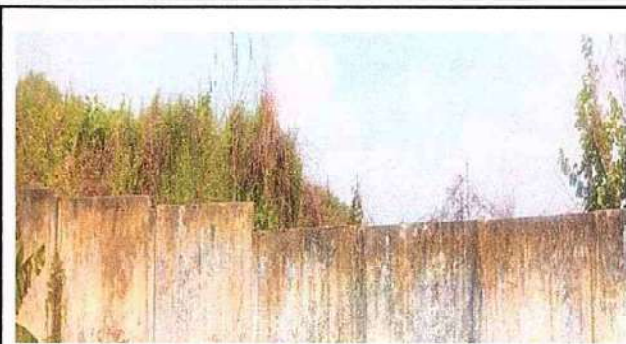
Foto 2: Pintura en muro perimetral
