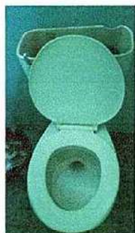
Foto 5: 10.3 Sustitución de inodoro.
