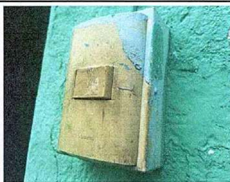
Foto 10: 17.6 Sustitución de interruptor simple.
