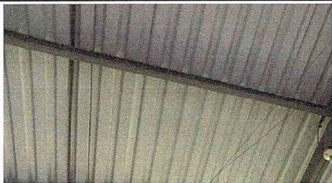
Foto 13: 17.12 Sustitución de ducto eléctrico más accesorios.
