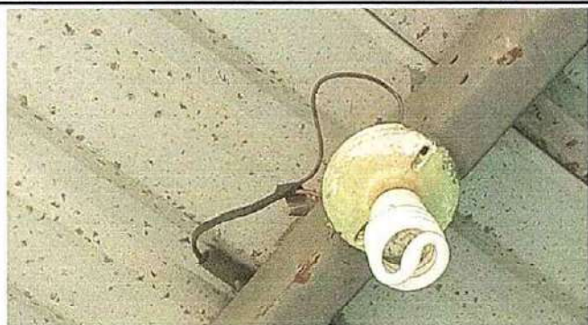
Foto 9: 17.5 Sustitución de plafoneras.
