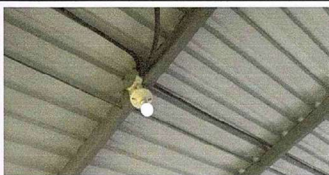
Foto 8: 17.4 Sustitución de focos ahorradores
