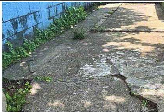
Foto 2: 6.1 Reparación de piso de torta de concreto.
