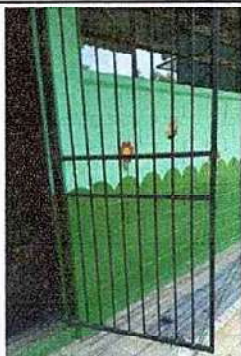
Foto 7: 11.1 Mantenimiento a barandas de metal.
