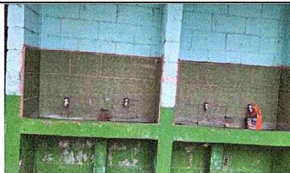
Foto 6: 10.10 Sustitución de llave de paso.
