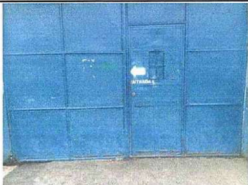
Foto1: 4.1 Sustitución de portón de metal.
