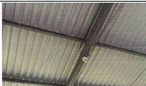
Foto 12: 17.11 Reparación de cableado eléctrico.
