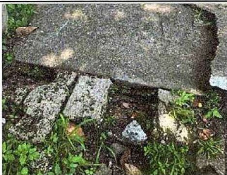
Foto 3: 6.5 Sustitución de piso de torta de concreto.
