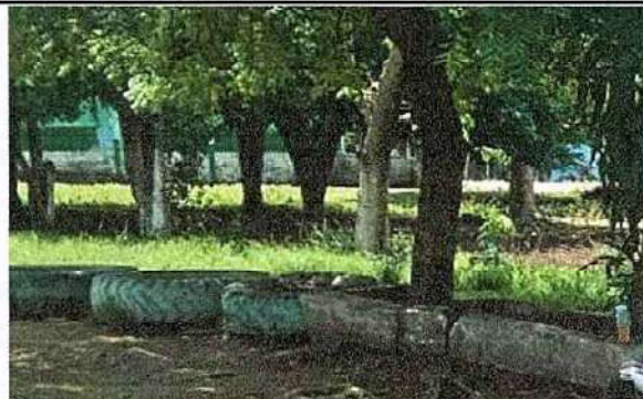
Foto 4: 8.2 Reparación de banqueta de concreto.
