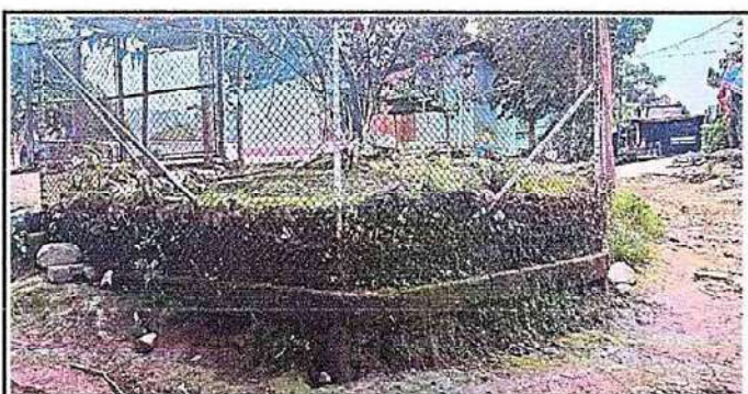
Foto 5: Reforzamiento al muro perimetral y cambio de malla
