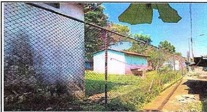
Foto 4: La malla se encuentra rota en diferentes áreas del perímetro
