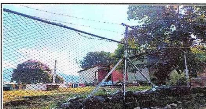
Foto 6: Cambio de tubos galvanizados para dar firmeza a la malla.
