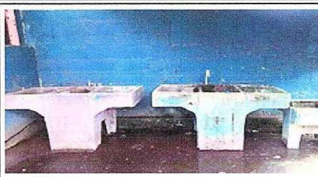
Foto 8: Reparacion de drenaje e instalacion de tuberia de agua
