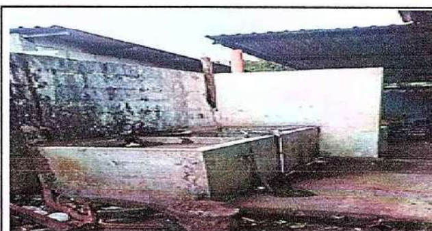
Foto 6: Sustitucion de lamina por lamina troquelada
