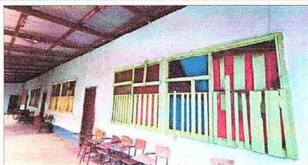
Foto1: Sustitucion de ventana de madera por metal
