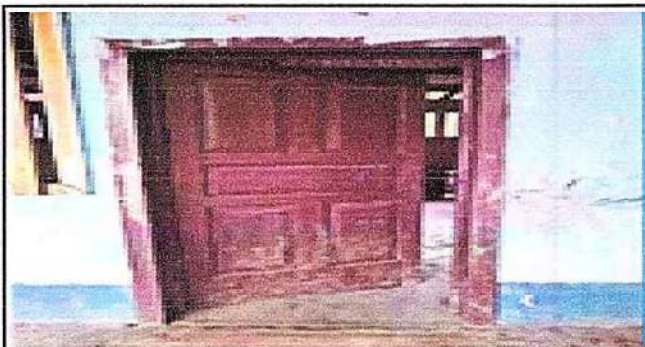
Foto 3: Remozamiento de puerta y sustitucion de chapa
