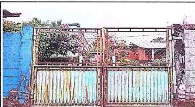
Foto 4: Sustitucion de porton principal
