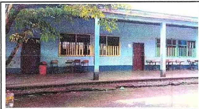
Foto 9: Pintura de muros interiores y exteriores
