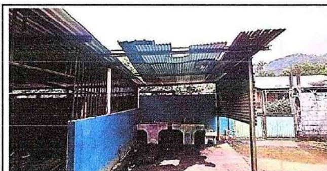
Foto 5: Pintura en muros exteriores e interiores
