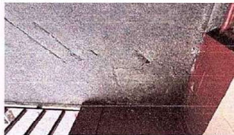
Foto 15: 21.4. Sellado en grietas y fisuras en muros
