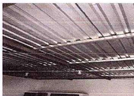
Foto 2: 2.2 Sustrución de estructura de soporte de madera, por metal
