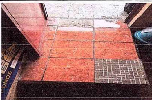
Foto 4: 6.8 Sustrución de piso ceramico.
