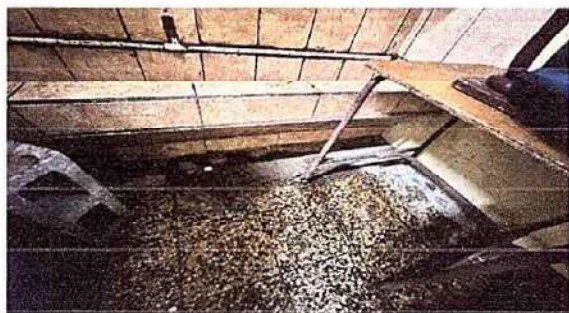
FOTO 7: 13.1 Sustitución de azulejo
