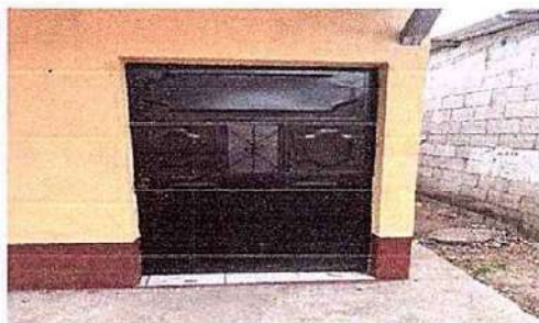
Foto 9: 19.6 Fabricación e instalación de puerta de rejas
