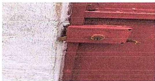
Foto 3: 4.2 Sustrución de chapa.
