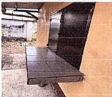
Foto 8: 19.2 Fabricación e instalación de balcones de hierro en ventana
