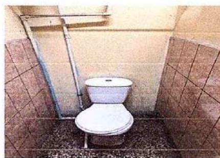
FOTO 7: 13.1 Sustitución de azulejo
