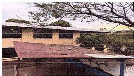
Foto 10: 19.8 Instalación de lámina troquelada aluzinc
