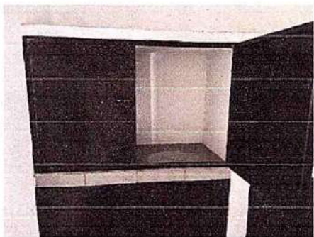
FOTO 7: 13.1 Sustitución de azulejo
