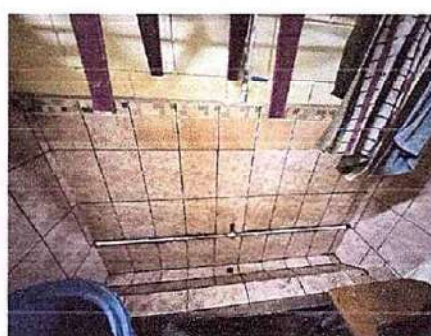
FOTO 7: 13.1 Sustitución de azulejo
