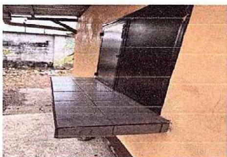
FOTO 7: 13.1 Sustitución de azulejo
