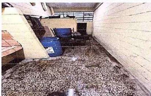
Foto 5: 6.8 Sustrución de piso ceramico.
