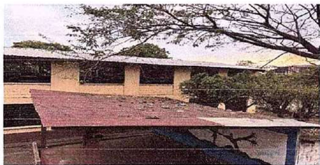
Foto1: 1.1. Sustrución de lámina, por lamina troquelada aluzinc calibre 26.
