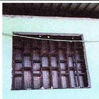
Foto 4: 5.2 Sustitución de estructura de metal de ventana
