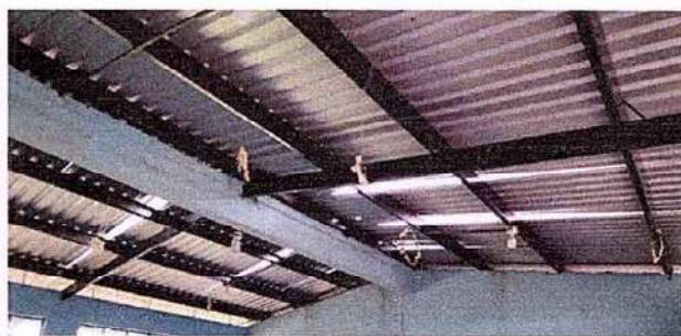
Foto 2: 1.2 Sustitución de capote de lamina para lamina troquelada 1.3 Sustitución de elementos de fijación
