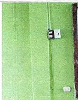
Foto 9: 17.8 Sustitución de tomacorrientes dobles
