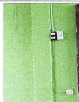
Foto 10: 17.11 Reparación de cableado electrico
