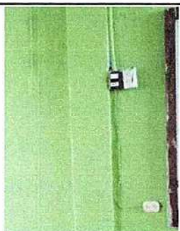
Foto 11: 17. 12 sustitución de ducto eléctrico + accesorios
