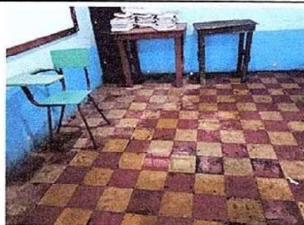
Foto 6: 6.13: Sustitución de cemento liquido por piso cerámico
