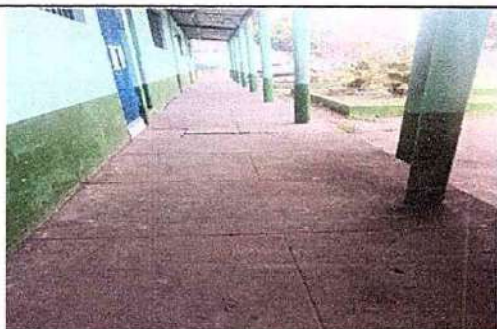
Foto 5: 6.12: Sustitución de piso de concreto por piso de granito
