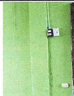
Foto 8: 17.8 Sustitución intrruptores dobles
