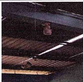
Foto7: 17.3 Sustitución de lamparas tipo LED
