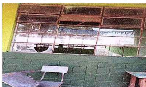
Foto 2: SUSTITUCION DE ESTRUCTURA DE METAL DE VENTANA
