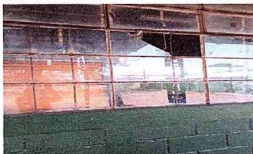
Foto1: SUSTITUCION DE ESTRUCTURA DE METAL DE VENTANA
