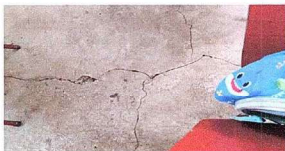
Foto 5: SUSTITUCION DE PISO DE CEMENTO LIQUIDO
