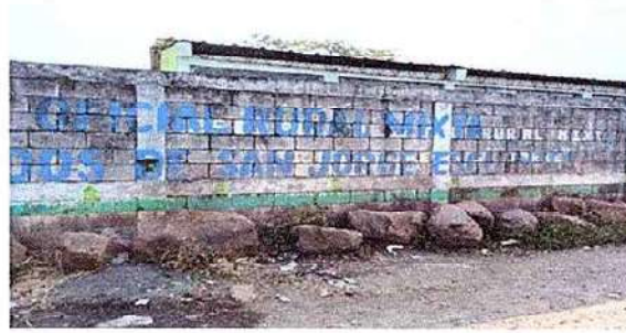
Foto 6: PINTURA EN MUROS EXTERIORES E INTERIORES
