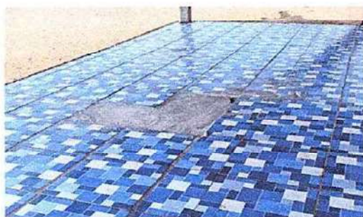
Foto 3: REPARACION DE PISO CERAMICO
