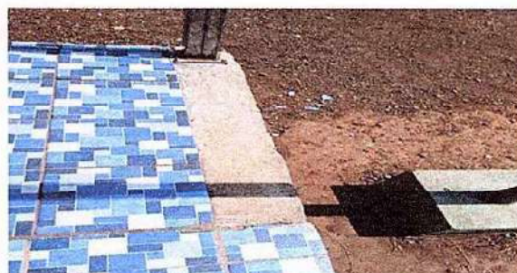
Foto 4: REPARACIÓN DE PISO CERAMICO
