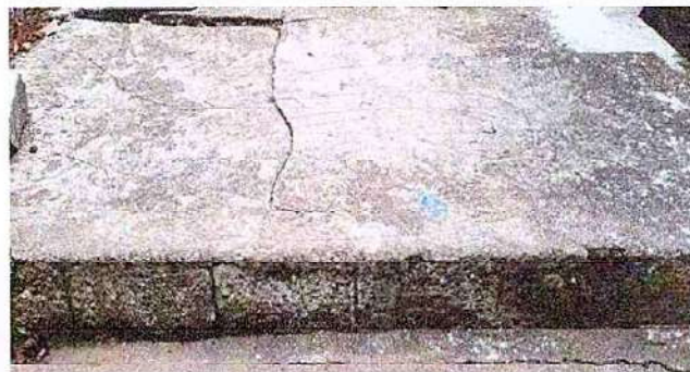
Reparación de piso de torta de concreto
