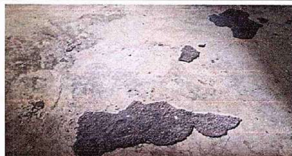
Foto 4: 6.10-Sustitución de piso de concreto por piso cerámico en los salones de clase
