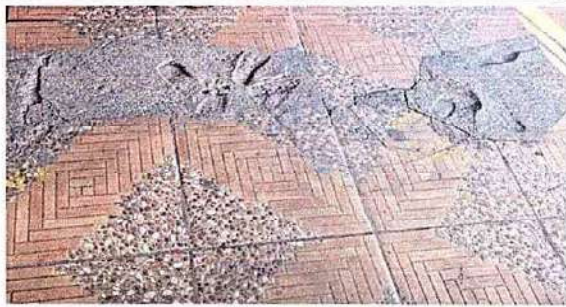
Foto 3: 6.8- Sustitución de piso cerámico
