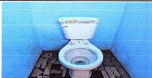
Foto 5: 10.3- Sustitución de sanitarios y piso cerámico
