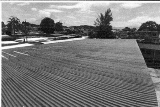
Foto1: 1.CUBIERTA DE LAMINA 1.1. Sustitución de lamina, por lámina troquelada azulinc calibre 26.
