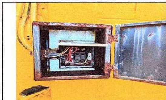
Foto 5: Instalación e acometida electrica
