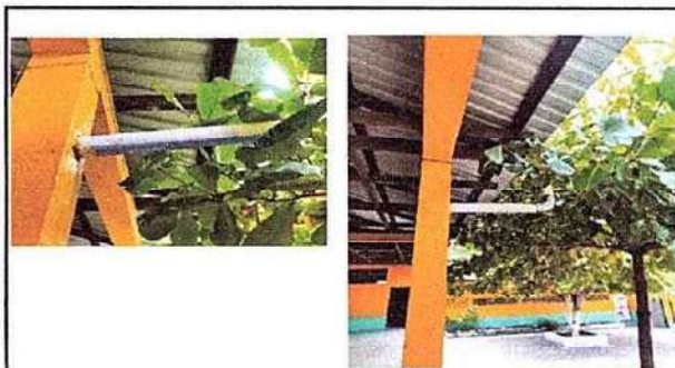
Foto 6: sustitución de bajadas de agua pluvial
