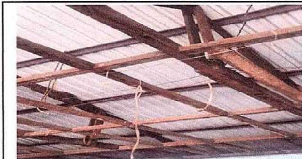
Foto 3: Instalación de unidades de luz (incluye interruptor y cable eléctrico)
