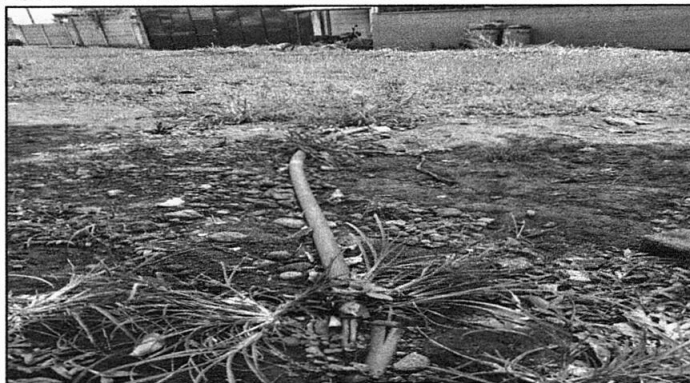
Foto 8. Sustitución de ducto eléctrico de la acometida.
