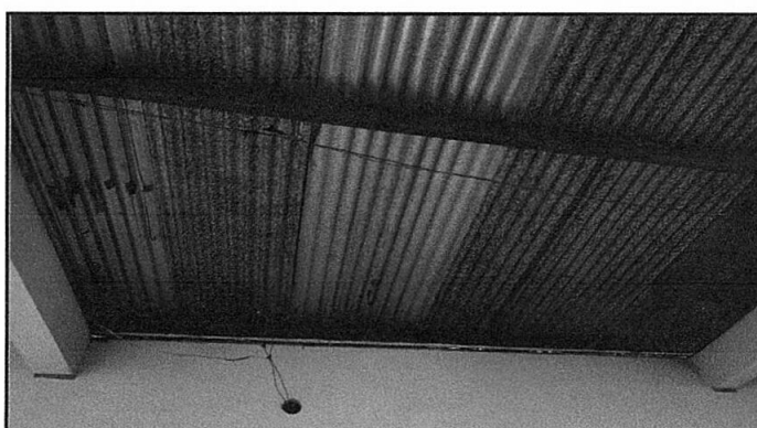
Foto 4: Sustitución de Cable eléctrico en corredor
