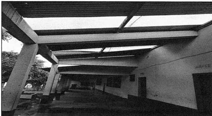
Foto 1. Sustitución de Lamina Troquelada Alizinc calibre 26 en corredor y sustitución de plafoneras y bombillas en corredor.
