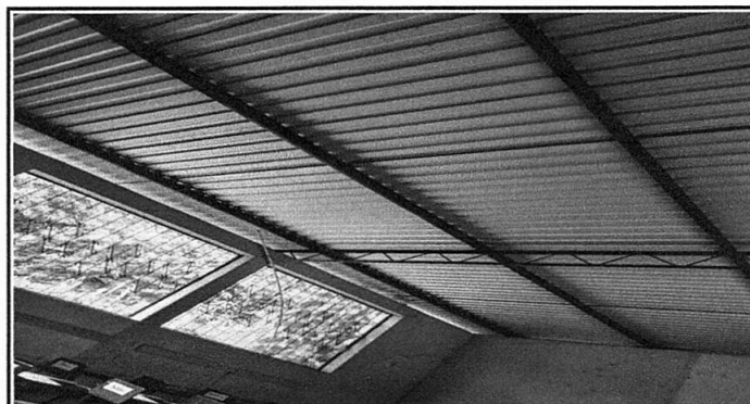
Foto 11: Sustitución de Plafoneras y bombillas en aulas.
