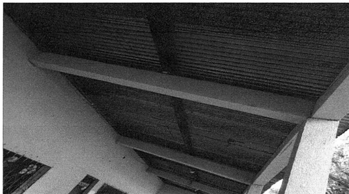
Foto 2. Sustitución de Estructura Metalica en corredor.
