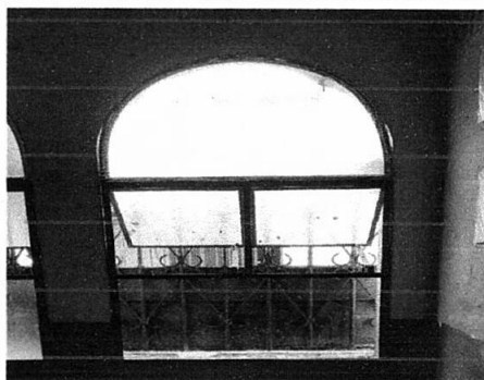
Foto 5: Modificación de 28 ventanas, para mejorar la ventilación de las aulas.
