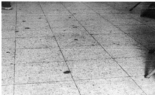
Foto 1: Sustrucción de piso de granito por piso ceramico en 03 aulas del centro educativo.
