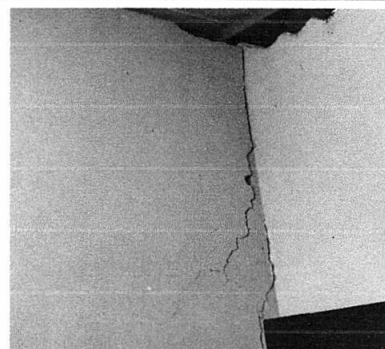
Foto 6: Repello y reparación de grieta profunda, la grieta abarca 3.50 metros de alto por 1.50 metros de ancho.
