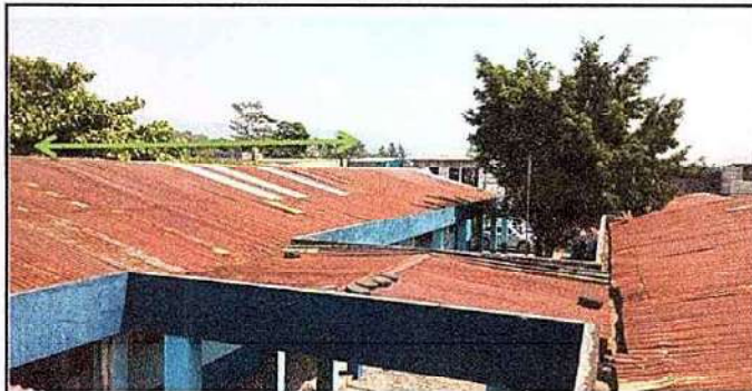
Foto 2: 1.2 Sustitucion de capote de lámina por lámina troquelada 1.3 Sustitucion de elementos de fijación
