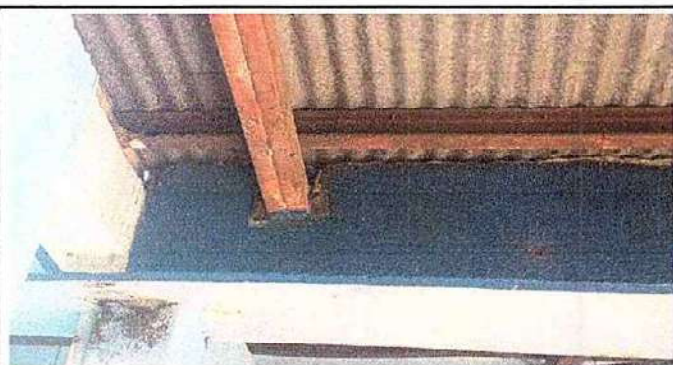
Foto 3: 2.1 Mantenimiento a estructura de soporte de metal
