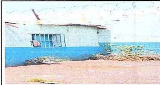
Foto3: 5.2 Sustitución de estructura de metal de ventana
