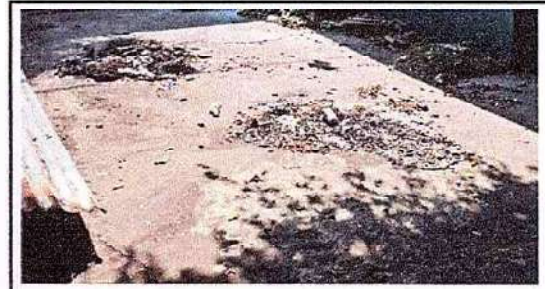
Foto4: 6.1 Reparación de piso de torta de concreto
