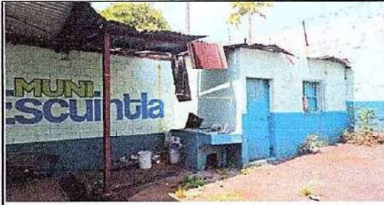
Foto1: 1.1 Sustitución de lámina por lámina troquelada calibre 26
