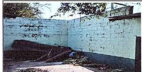
Foto6: 15.1 Reparación de muro perimetral de block
