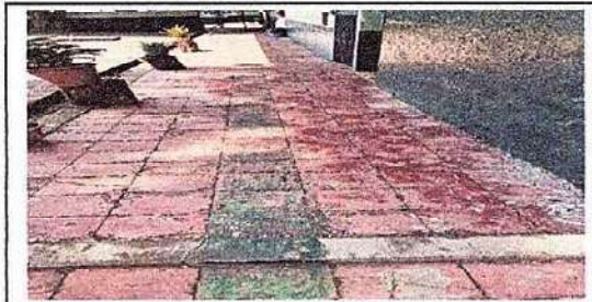
Foto5: 6.8 Sustitución de piso cerámico
