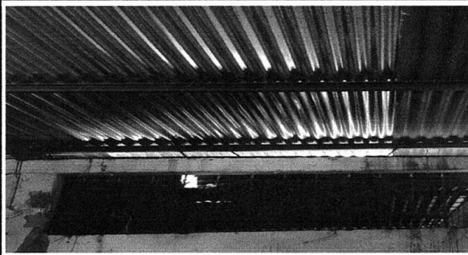
Foto 4: Reparación de muro de block en área de aula.
