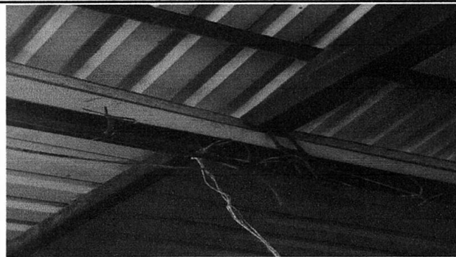
Foto 2: Reparación de cableado eléctrico.
