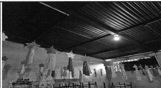
Foto 2: Sustrucción de lamina por lamina calibre 26.
