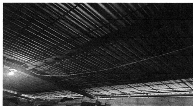
Foto 4: Mantenimiento estructura de soporte de metal.
