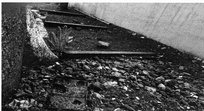
Foto 3: Reparación de plancha de concreto de patio.
