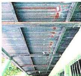
Foto 1.1: Sustrución de lámina por lámina
