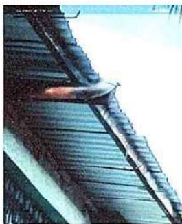
Foto 7.1: Sustrución de canal de metal
