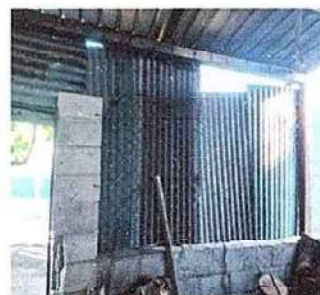
Foto 15.1: Reparación de muro perimetral de block
