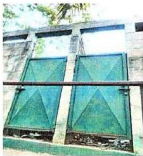
Foto 4.1: Mantenimiento a estructura (lijado, cambio de tubo, sepillado, sujeciones, aplicación de pintura)
