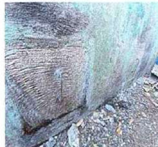
Foto 14.2: Mantenimiento a cajas de registro
