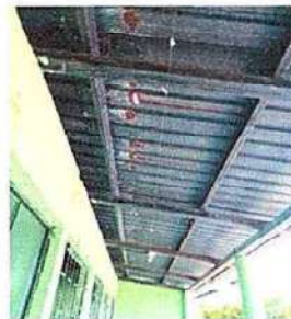
Foto 2.2: Mantenimiento a estructura de soporte de metal
