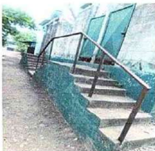
Foto 11.2: Sustitución de baranda de metal
