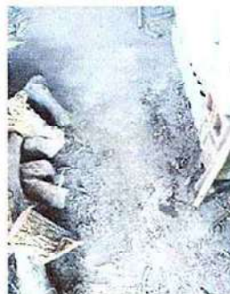
Foto 6.1: Sustrución de torta de concreto
