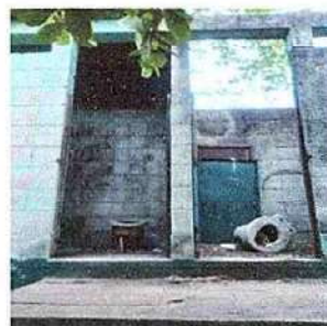
Foto 19.4: Fabricación e instalación de puertas de metal en baños
