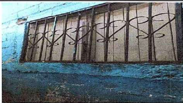
Foto 5: 5.3 Sustitución de 3 ventanas de madera por ventana de vidrio
