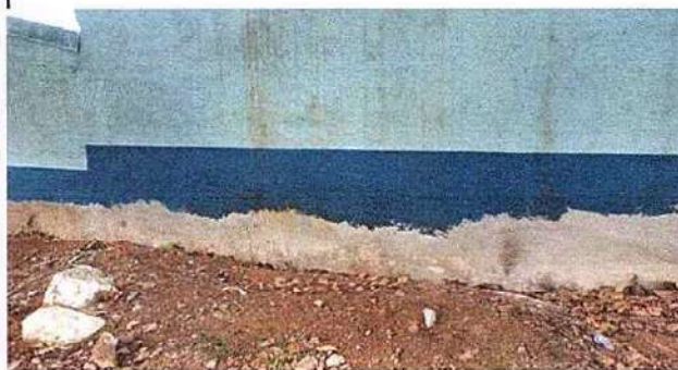
Foto 8: 9.1 Pintura en muros interiores y exteriores
