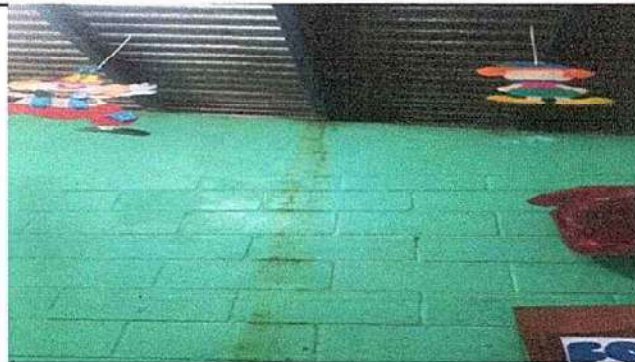
Foto 2: 2.1: Mantenimiento de soporte de Estructura de Metal
