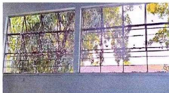
Foto 4: (Ventanas) 5.7 Mantenimiento de balcones de metal
