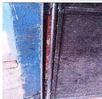
Foto 2: (4 Puerta) 4.3 Sustitución de puertas
