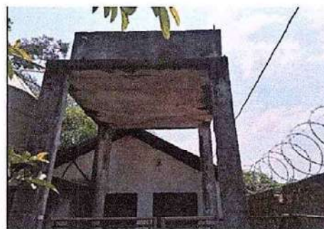
Foto 10: (18 Reparación de Cisterna / depósitos de agua) 18.4 Reparación de cisterna de concreto
