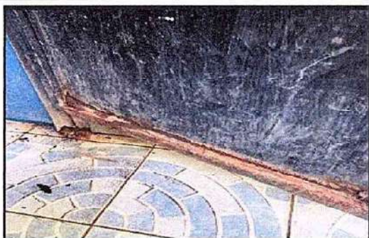
Foto 1: (4 Puerta) 4.1 Mantenimiento de estructura (lijado, cambio de tubo, cepillado sujeciones, aplicación de pintura)
