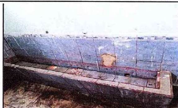
Foto 8: (10 Servicios sanitarios y accesorios) 10.6 Sustitución de llave de migitorio
