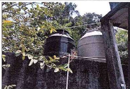
Foto 9: (14 Reparación de Red de Drenaje y Red de agua potable) 14.1 Sustitución de llave de globo
