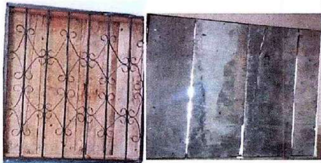
Foto 3: (Ventanas) 5.3 Sustitución de ventana de madera por metal mas vidrio
