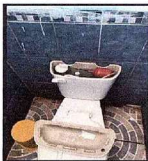
Foto 7: (10 Servicios sanitarios y accesorios) 10.2 Sustitución de accesorios inodoros (contra llave, tubo de abasto y tanque)
