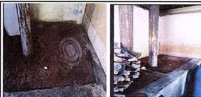
Foto 12: (20 Reparación de Cocina) 20.3 Sustitución de plancha de metal 3 hornilla, 20.6 Sustitución de chimenea de metal
