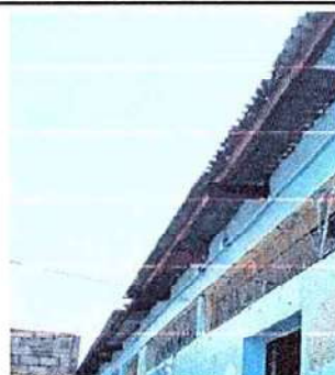
Foto 2: 1.3 Sustitucion de elementos de fijacion
