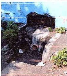
Foto 5: 7.4. Sustitucion de bajada de agua pluvial de metal por tubo PVC 3"
