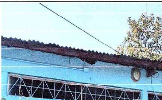
Foto 3: 2.Sustitucion de estructura de soporte de metal por metal.
