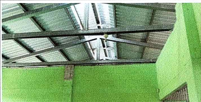
Foto1: 2.1 Mantenimiento a estructura de soporte de metal
