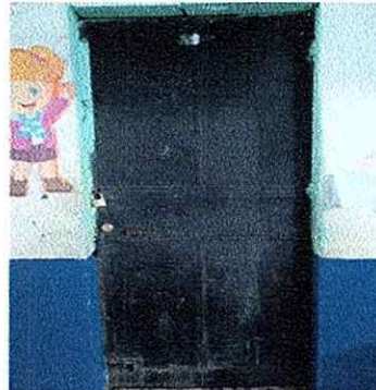
Foto 8: 19.3 Fabricación e instalación de puertas de metal en módulos
