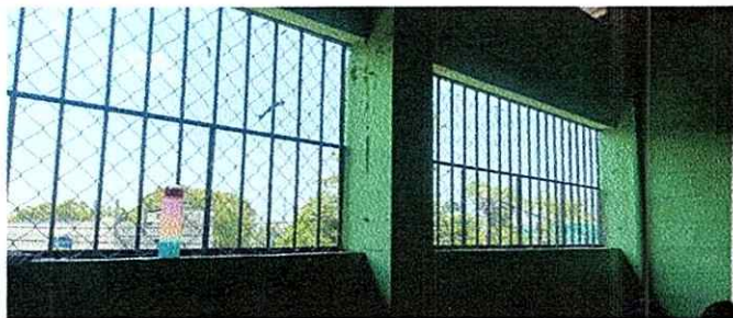
Foto 3: 5.2 Sustitución de estructura de metal de ventana
