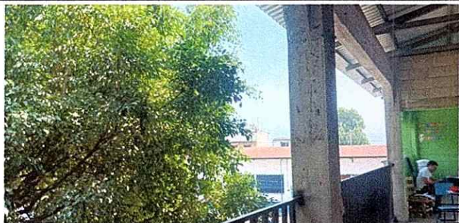
Foto 10: 11.2 Sustitución de barandas de metal.
