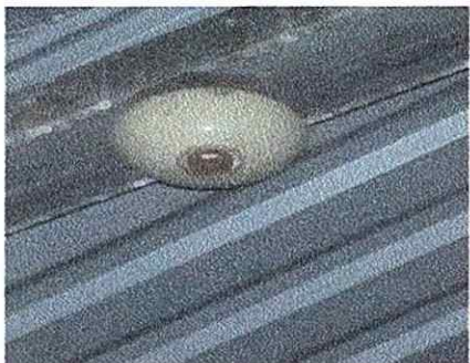
Foto7: 17.5 Sustitución de plafoneras
