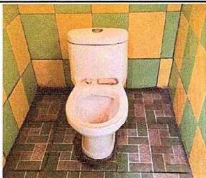
Foto 7: Sustitucion de inodoro
