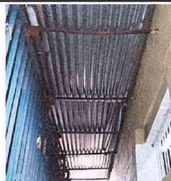
Foto 2: 1.3 Sustitución de estructura de soporte de metal por metal
