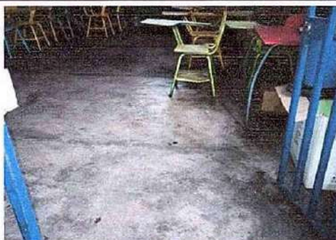
Foto 3: 6.10 Sustitución de piso de concreto por piso cerámico.
