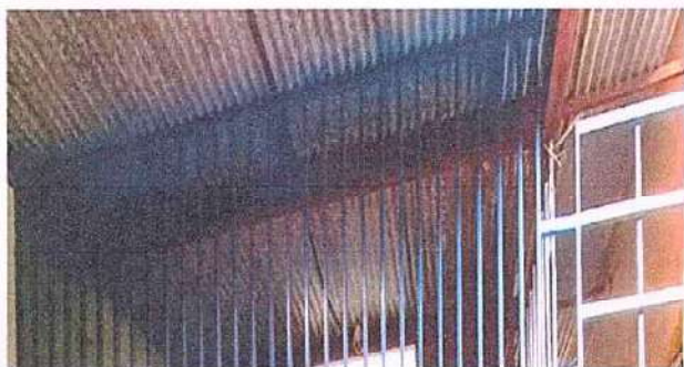
Foto 1: 1.1. Sustitución de lámina , por lámina troquelada aluzinc c26
