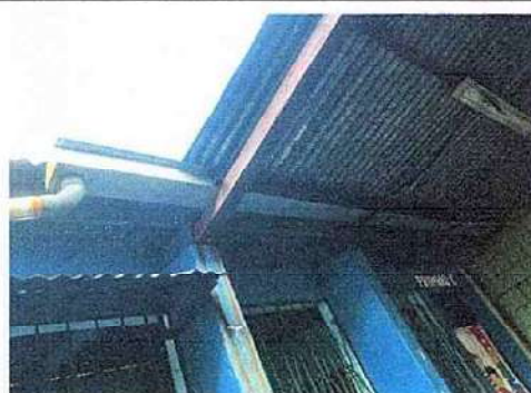
Foto 4: 7.1 Sustitución de canal de metal.
