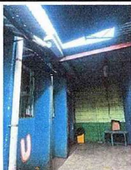
Foto 5: 7.4. Sustitución de bajada de agua pluvial de metal por tubo PVC 3"
