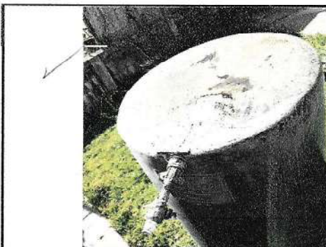
Foto 6: Deposito de agua
