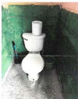
Foto7: Sustrucion de inodoro
