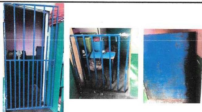
Foto 3: sustrucion de puerta, sustrucion de puerta en servicio sanitario,
