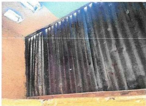
Foto 1: Sustrucion de lámina, por lámina troquelada
