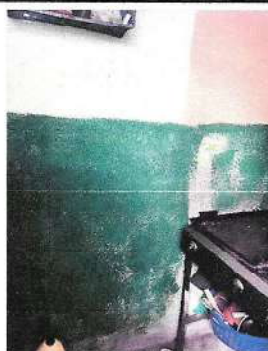
Foto 10: Repello en muro
