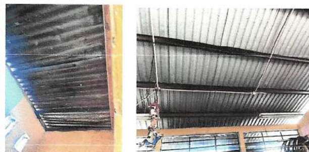
Foto 6: Mantenimiento de estructura de meta; sustrucion de estructura de soporte de madera, por metal; sustrucion de estructura de soporte de metal, por metal.
