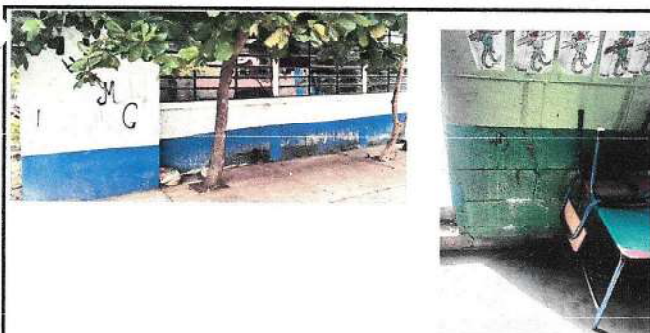
Foto 5: Pintura en muro de exteriores e interiores
