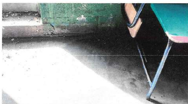
Foto 9: Sustrucion de piso ceramico
