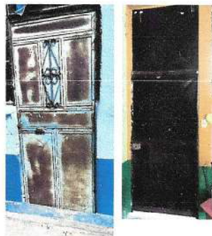
Foto 2: Mantenimiento a estructura, sustrucion de chapa
