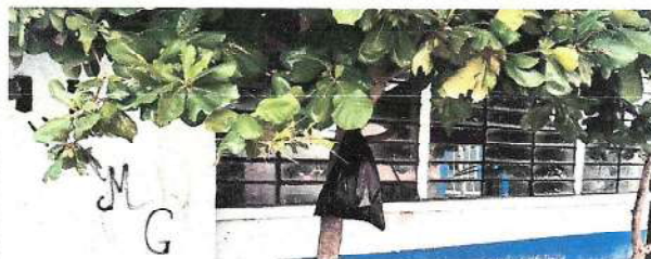
Foto 4: Mantenimiento de estructura de metal en ventana, sustrucion de vidrios
