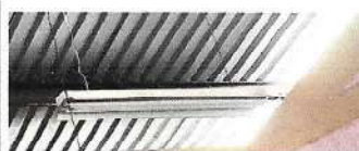
Foto 8: Sustrucion de lamparas de 2x40
