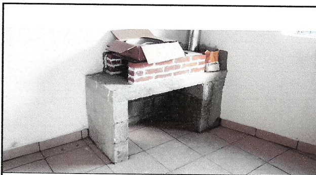
Foto 11: Instalacion de cocina rural
