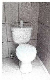
Foto 10: Instalación de azulejos
