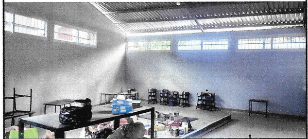
Foto 2: Instalación de Ventanas PVC
