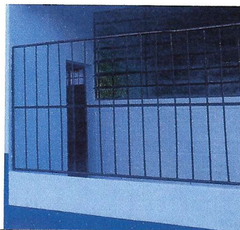
Foto 8: Mantenimiento de balcones
