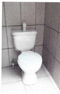
Foto7: Sustrucción de servicios sanitarios
