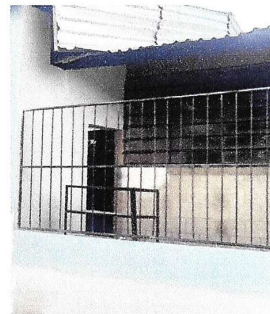
Foto 8: Mantenimiento de balcones
