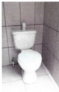
Foto7: Sustrucción de servicios sanitarios
