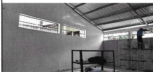
Foto 12: Repello en paredes
