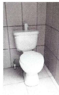
Foto 10: Instalación de azulejos
