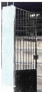
Foto 9: Mantenimiento de portón
