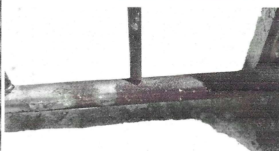
Foto 8: Mantenimiento de balcones
