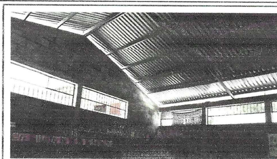
Foto 2: Instalación de Ventanas PVC
