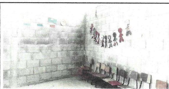
Foto 12: Repello en paredes
