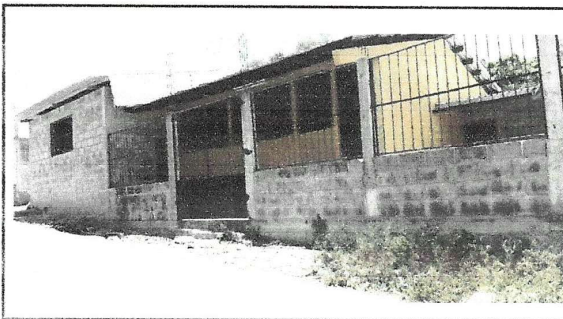
Foto 6: Pintura en muro interior y exterior
