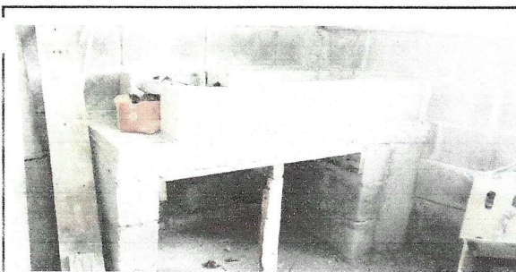
Foto 11: Instalación de cocina rural
