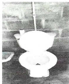
Foto 7: Sustitución de servicios sanitarios
