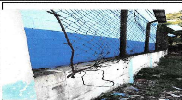
Foto 1: Modulo Muro Perimetral
