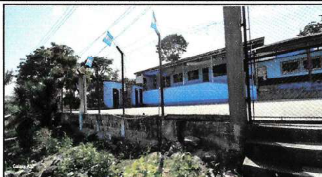
Foto 2: Modulo Muro Perimetral
