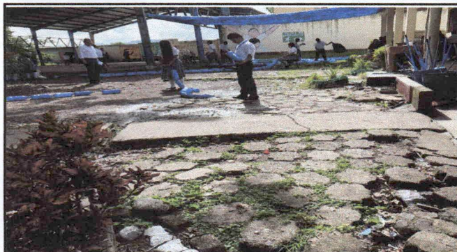
Foto 1: sustitución de adoquinado en una parte del patio del centro educativo
