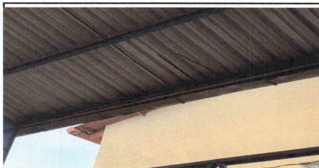
Foto 5: sustitución de capote de lámina en la cancha techada.
