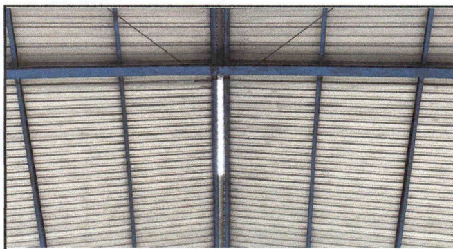
Foto 3: sustitución de capote de lámina en la cancha techada.
