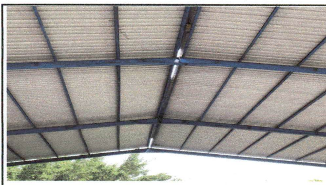
Foto 4: sustitución de capote de lámina en la cancha techada.
