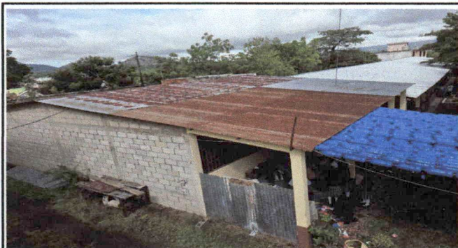
Foto 1: sustitución de lámina de dos aulas con corredor incluido del centro educativo
