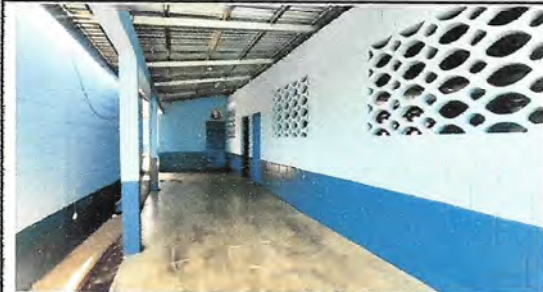
Foto 5: PINTURA EN MUROS EXTERIORES E INTERIORES
