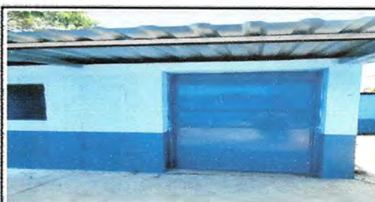
Foto 3.1: PUERTAS DE METAL
