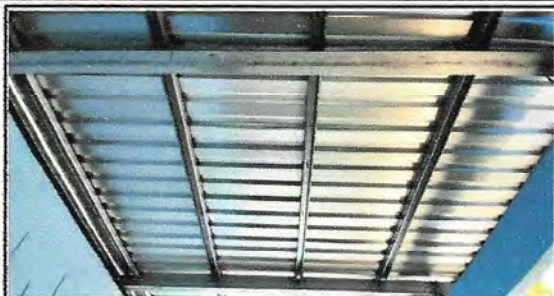
Foto1: CUBIERTA DE LAMINA
