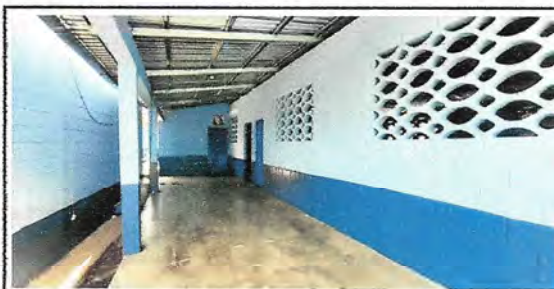
Foto 2: ESTRUCTURA DE TECHO
