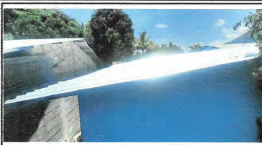
Foto 1.1: CUBIERTA DE LAMINA
