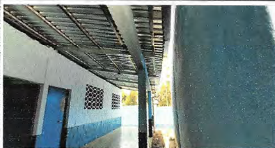
Foto 4: CANALES Y BAJADAS DE AGUA PLUVIAL
