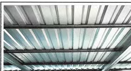
Foto 2.1: ESTRUCTURA DE TECHO
