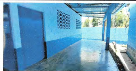
Foto 5.1: PINTURA EN MUROS EXTERIORES E INTERIORES
