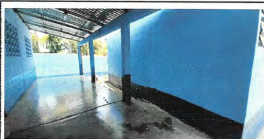
Foto 6: REPELLO Y CERNIDO A PAREDES
