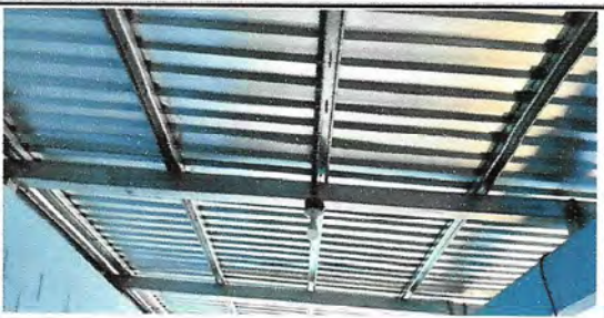
Foto 7: REPARACION DE SISTEMA ELECTRICO
