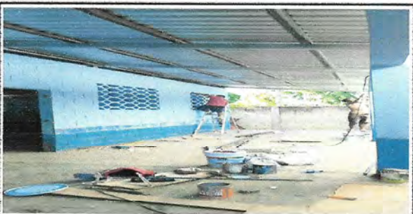
Foto 5.1: MODULO PINTURA EN MUROS EXTERIORES E INTERIORES
