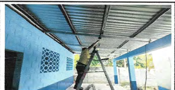
Foto 7: MODULO REPARACION DE SISTEMA ELECTRICO
