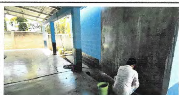
Foto 6: REPELLO Y CERNIDO EN PAREDES
