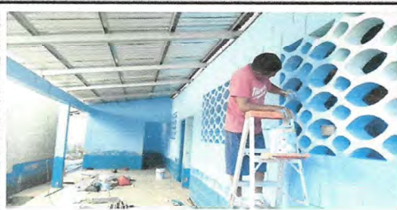
Foto 5: MODULO PINTURA EN MUROS EXTERIORES E INTERIORES
