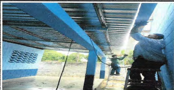
Foto 4: MODULO CANALES Y BAJADAS DE AGUA PLUVIAL
