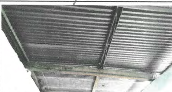
Foto 7: MODULO REPARACION DE SISTEMA ELECTRICO
