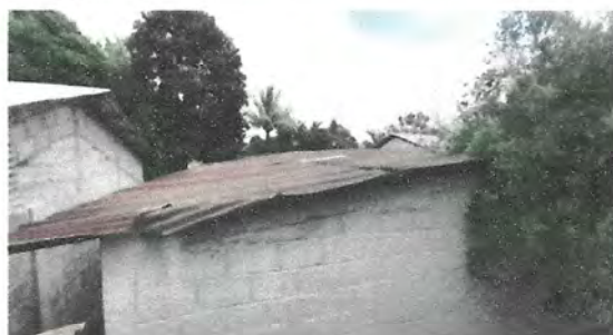
Foto 1.1 MODULO CUBIERTA DE LAMINA
