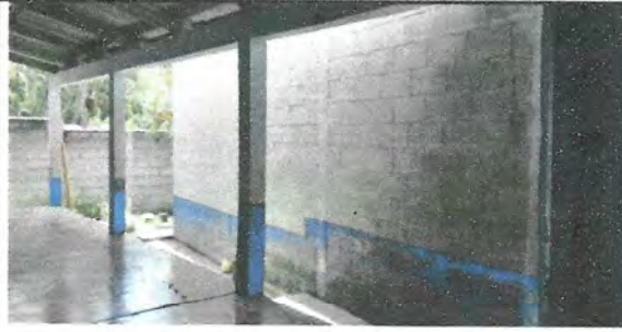
Foto 6: MODULO REPELLO Y CERNIDO DE PARED
