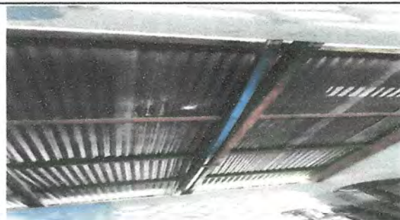
Foto1: MODULO CUBIERTA DE LAMINA
