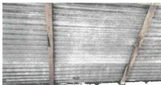
Foto 2.1: MODULO ESTRUCTURA DE TECHO
