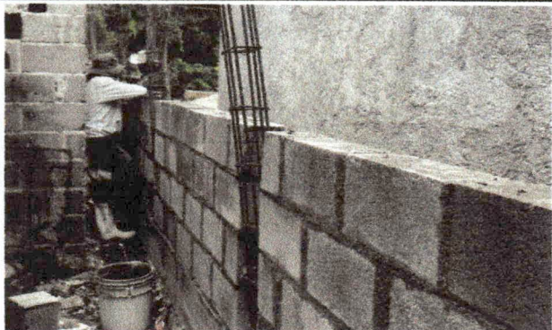
Foto 1: Reparación de muro perimetrol
