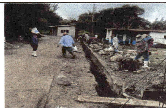
Foto 3: Reparación de Muro perimetrol
