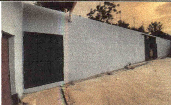
Foto 6: Pintura de muros exterior e interior
