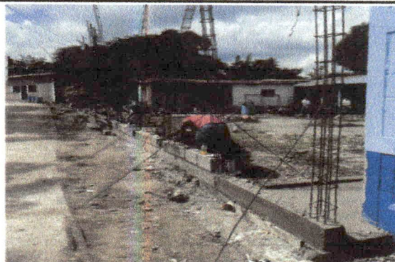
Foto 2: Reparación de muro perimetrol
