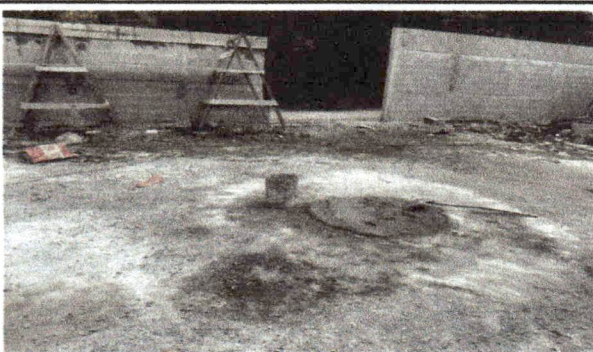
Foto 5: Reparación de plancha de concreto patio
