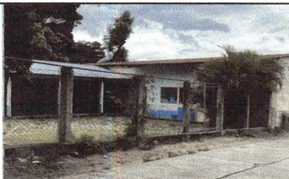
Foto 6: Pintura de muro exterior e interior.
