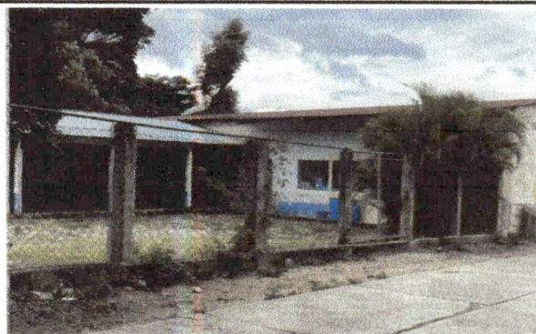
Foto 4: Reparación y mantenimiento de Portón y Puerto
