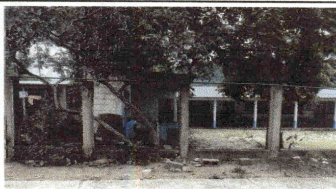
Foto 2: Reparación de muro perimetral
