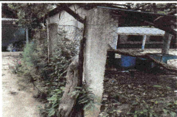
Foto 3: Reparación de muro perimetral
