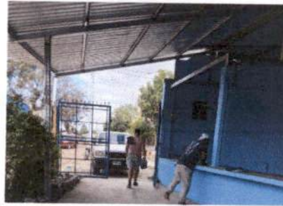
Foto 2: SUSTITUCIÓN ESTRUCTURA DE TECHO
