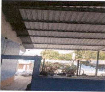
Foto1: SUSTITUCIÓN DE LAMINA
