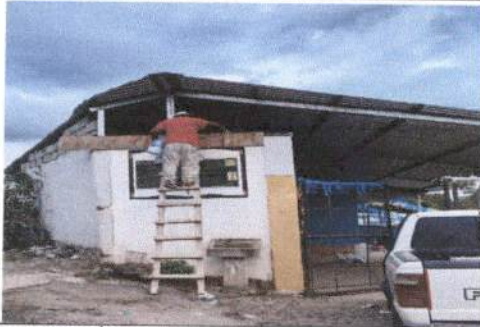
Foto1: SUSTITUCIÓN DE LAMINA
