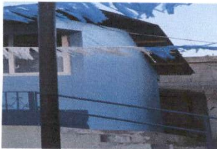
Foto 3: PINTURA MURO EXTERIOR
