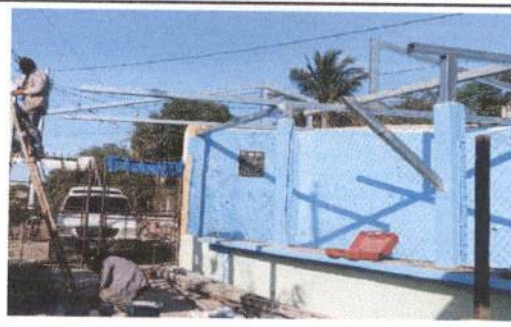
Foto 2: SUSTITUCIÓN ESTRUCTURA DE TECHO
