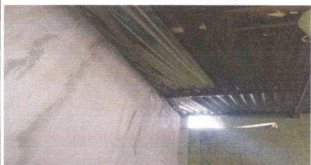
Foto 1: SUSTITUCIÓN DE LAMINA
