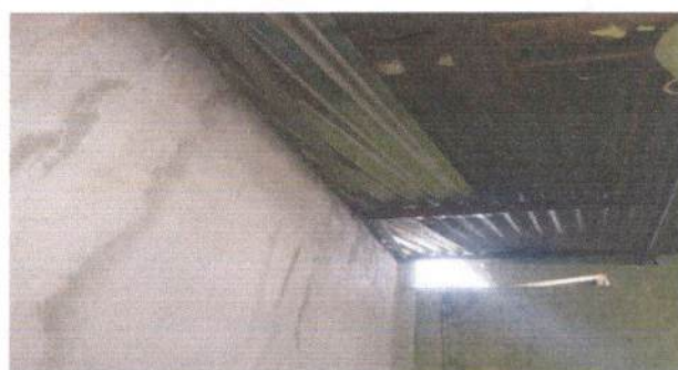
Foto 2: SUSTITUCIÓN ESTRUCTURA DE TECHO
