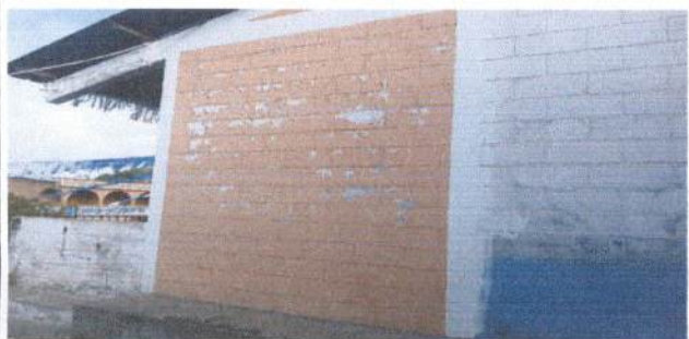
Foto 3: PINTURA MURO EXTERIOR
