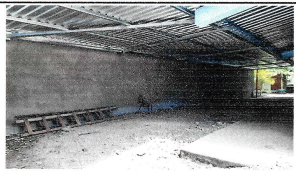
Foto 2: ESTRUCTURA DE TECHO
