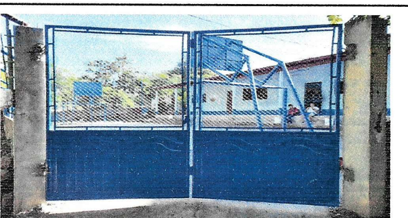
Foto 6: PORTON DE METAL
