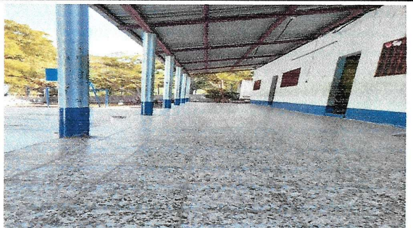
Foto 4: LOSA DE PATIO
