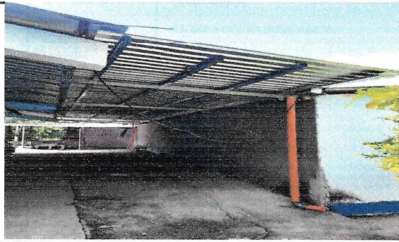
Foto 1: CUBIERTA DE LAMINA
