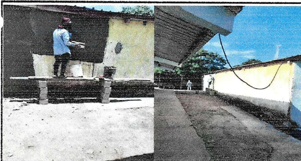
Foto 5: REPELLO Y CERNIDO A EXTERIORES
