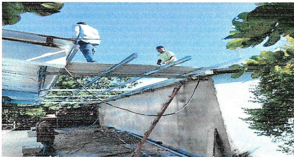
Foto 1: CUBIERTA DE LAMINA
