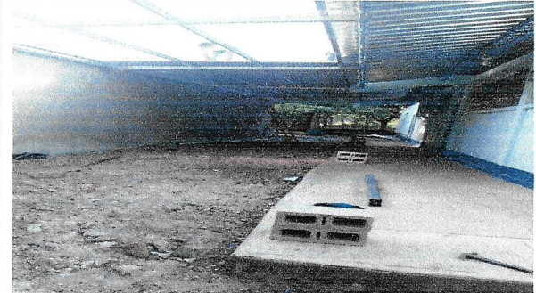
Foto 2: ESTRUCTURA DE TECHO
