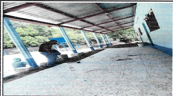
Foto 4: LOSA DE PATIO
