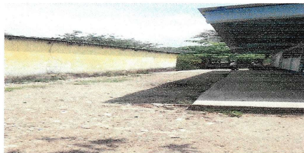
Foto 2: ESTRUCTURA DE TECHO
