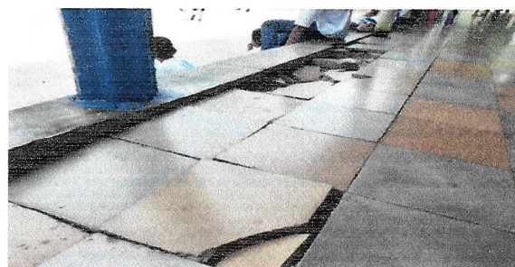
Foto 4: LOSA DE PATIO
