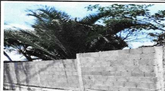
Foto 2: MODULO MURO PERIMETRAL
