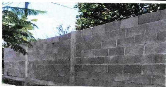
Foto 1: MODULO MURO PERIMETRAL
