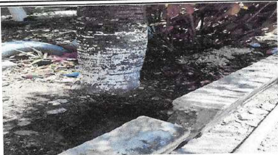
Foto 1: MODULO MURO PERIMETRAL
