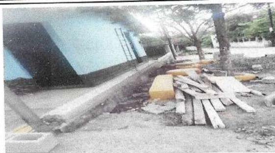
Foto 2: MODULO MURO PERIMETRAL
