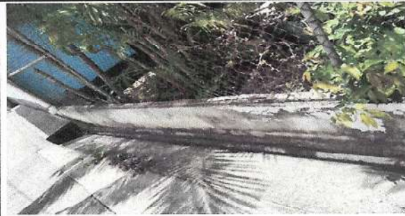
Foto 1: Módulo Muro Perimetral
