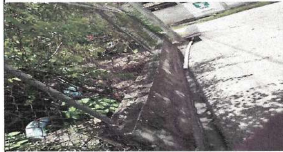
Foto 2: Módulo Muro Perimetral
